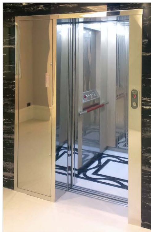
▲ 鏡面不鏽鋼板蝕刻+尾樓維修門
