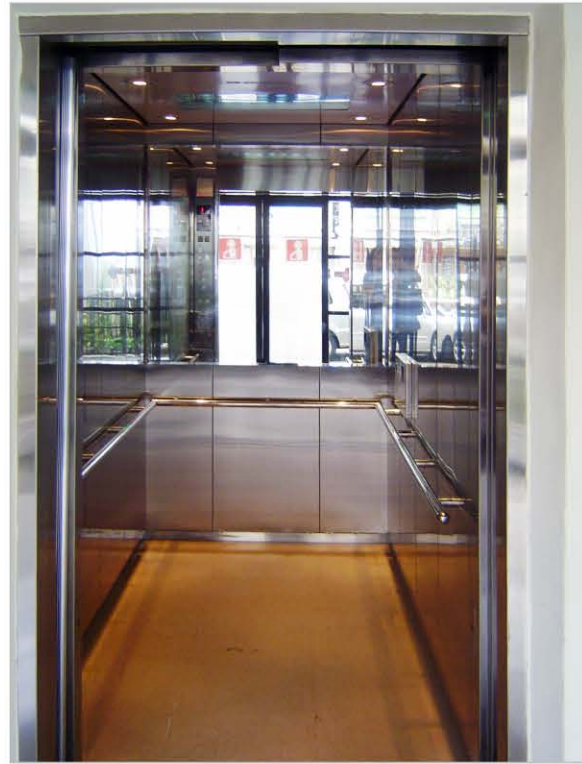
▲ 病床梯-車廂-髮紋不鏽鋼板製
